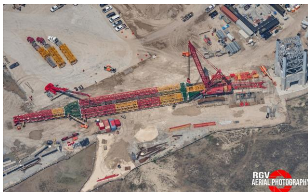
Кран Liebherr LR11350 (Фото от 18 мая, Сейчас на него устанавливают дополнительную стрелу для продолжения сборки башни)
