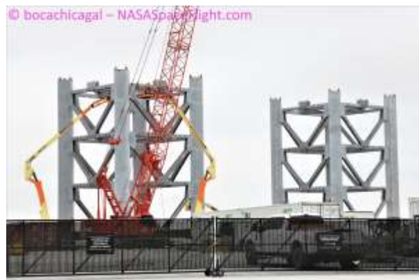
Секции, собираемые отдельно (почти готовы)
