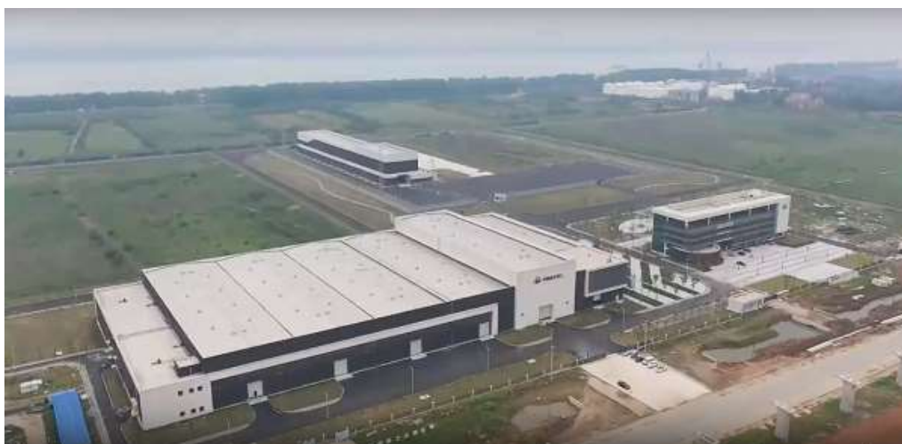
Завод по производству малых спутников в Ухане
