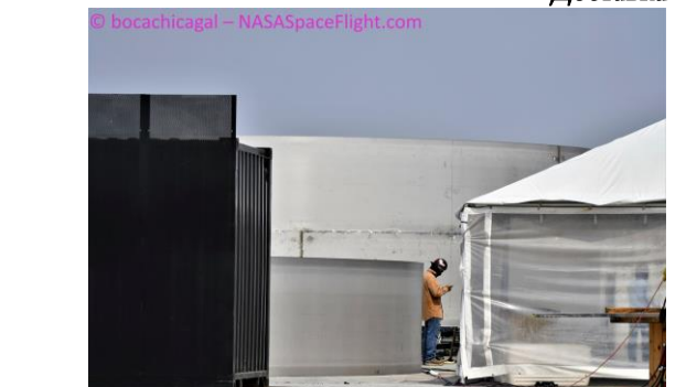
Корпус огромного резервуара
