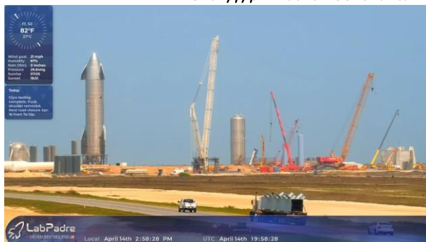
Стальная секция башни обслуживания
