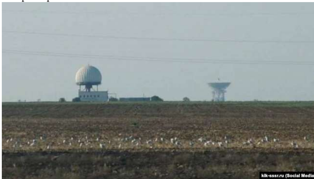
Трассовый радиолокационный комплекс в селе Витино Сакского района использовался для системы «Вымпел»
