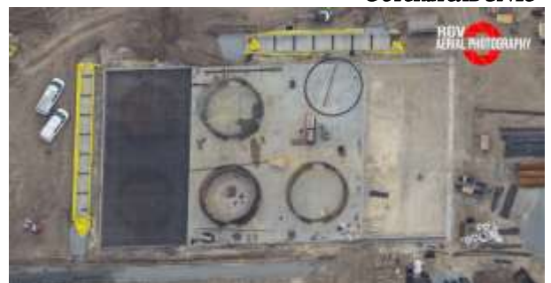
Строительство инфраструктуры площадки для орбитальных пусков
