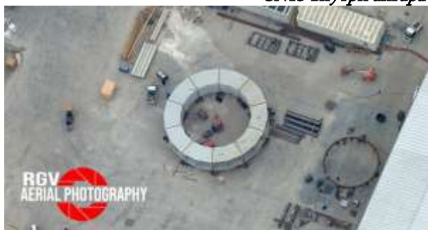
Сборка конструкции стола для орбитальных пусков
