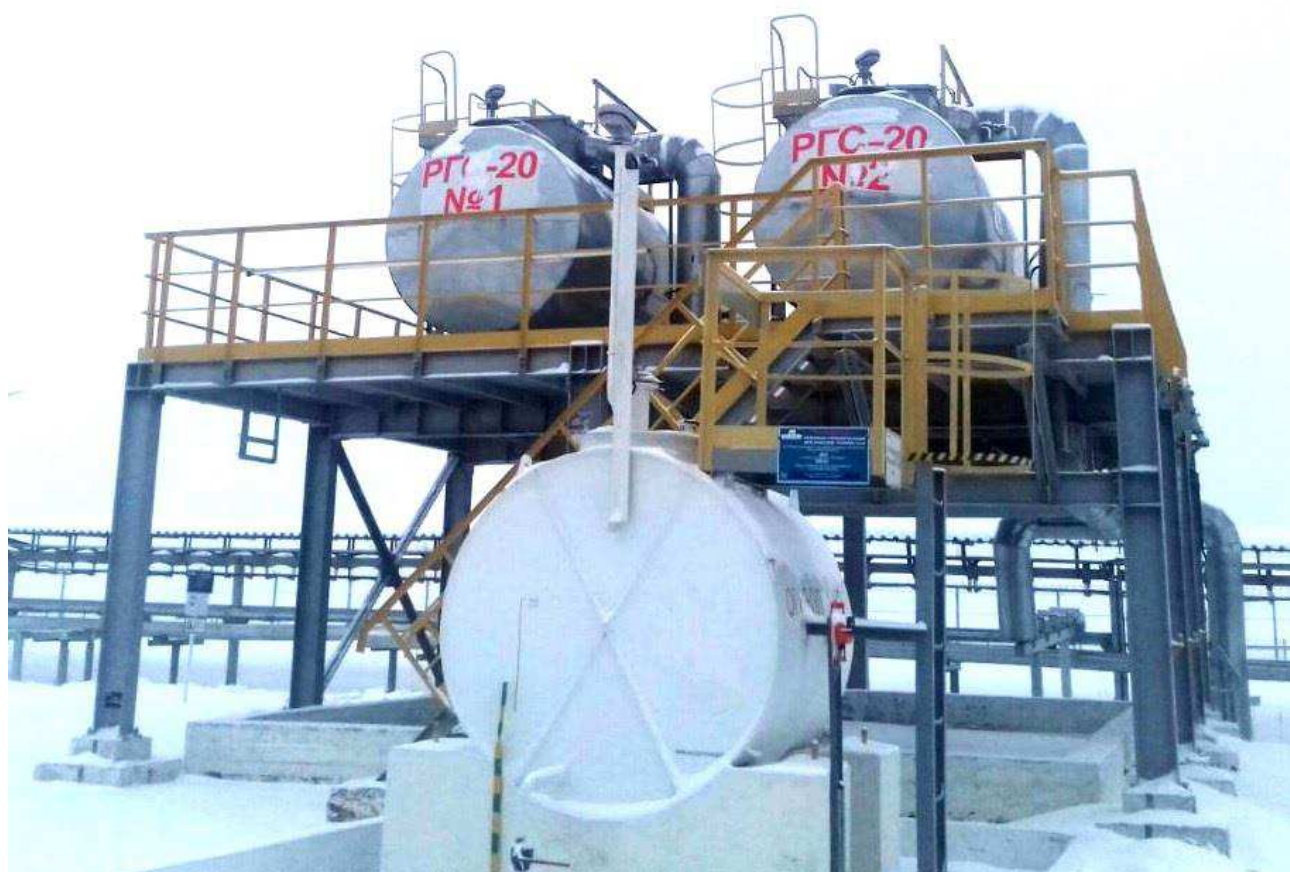
Рисунок 3 – Резервуар горизонтальный стальной – РГС-20.
