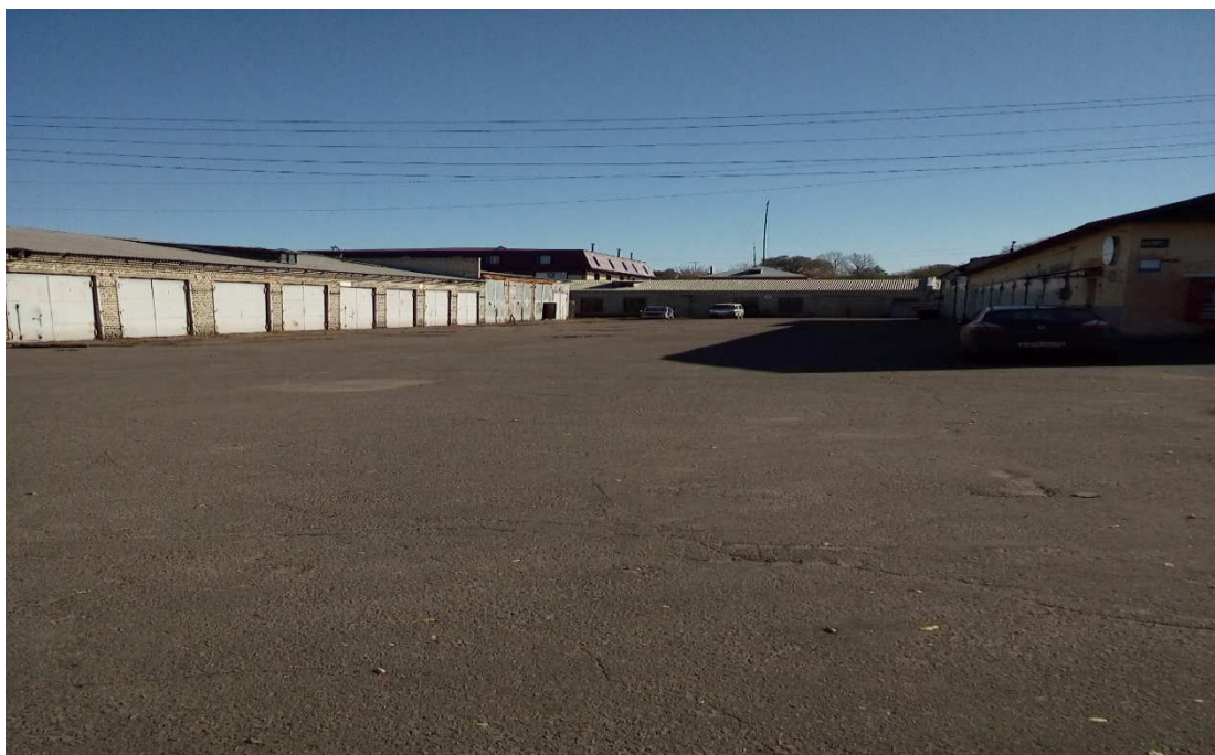
Рисунок 3 – Здание гаража, складские и производственные здания предприятия
