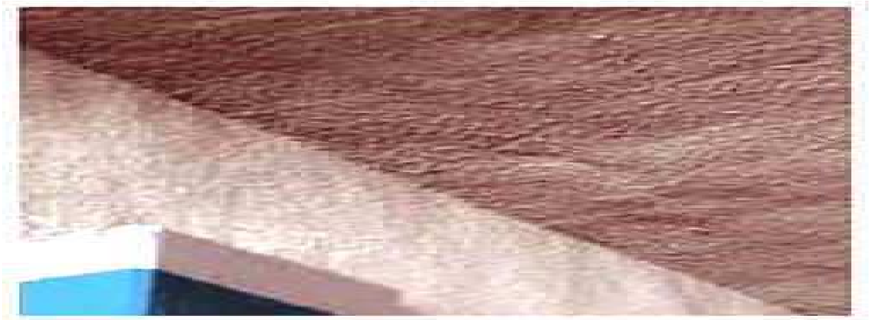
Рисунок 6 – Внешний вид обработанной поверхности железобетонной плиты огнезащитной пастой СОТЕРМ-1Б.
