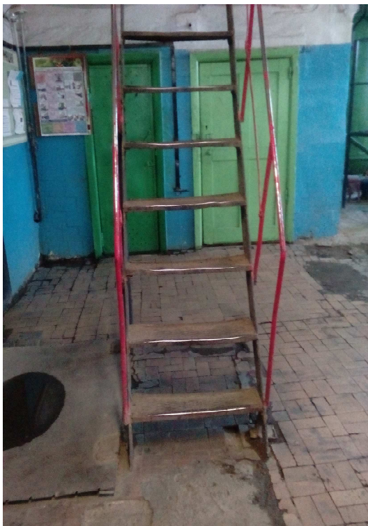
Внешний вид металлической лестницы в котельной
