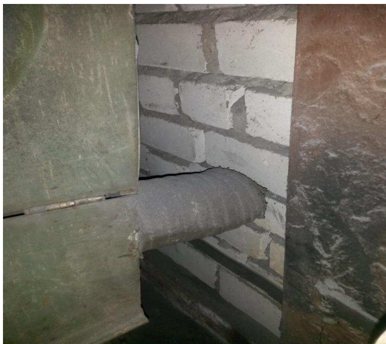
Рисунок 11 – Выход для воздуховодов на заточном станке
