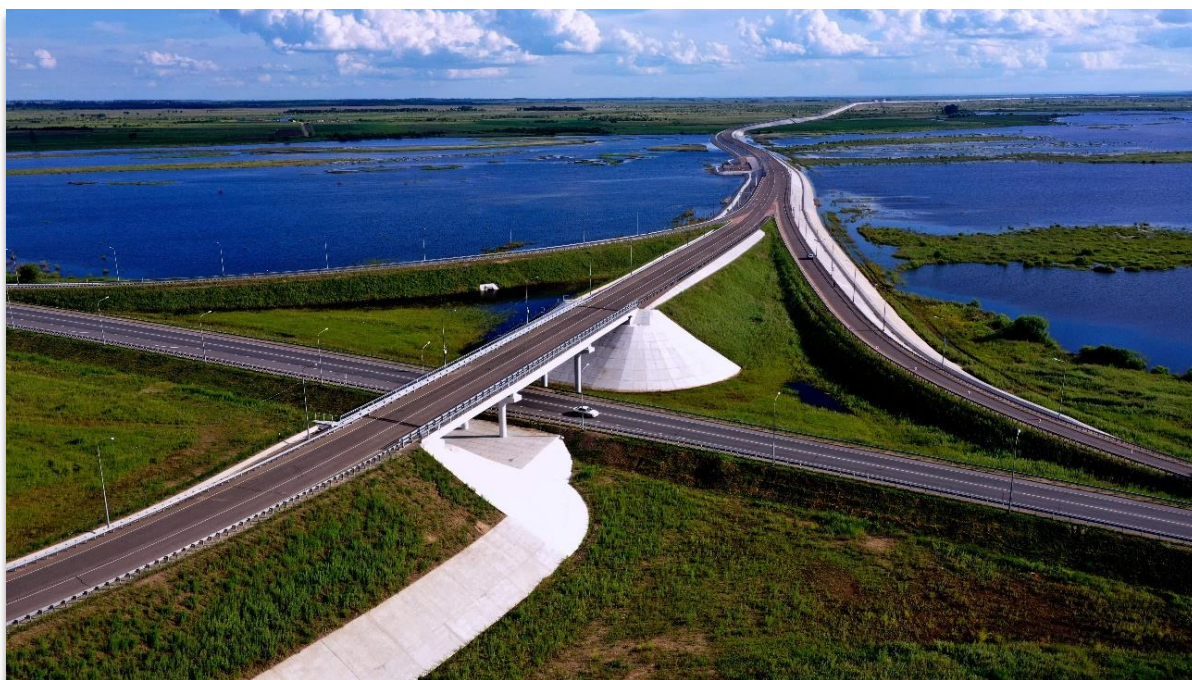
Рисунок 1 — Автомобильная дорога к мосту «Благовещенск-Хейхе»
