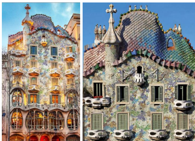
Рисунок 17 – Дом Батльо. Антонио Гауди, 1904 – 1906, Барселона
