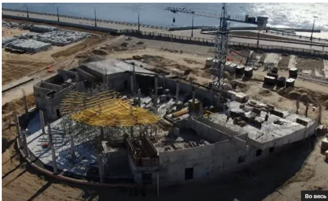
Рисунок А.1 – Состояние сооружения на сегодняшний день
