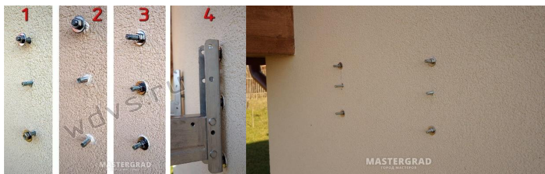
Рисунок В. 12 – Этапы установки шпилек резьбовые
