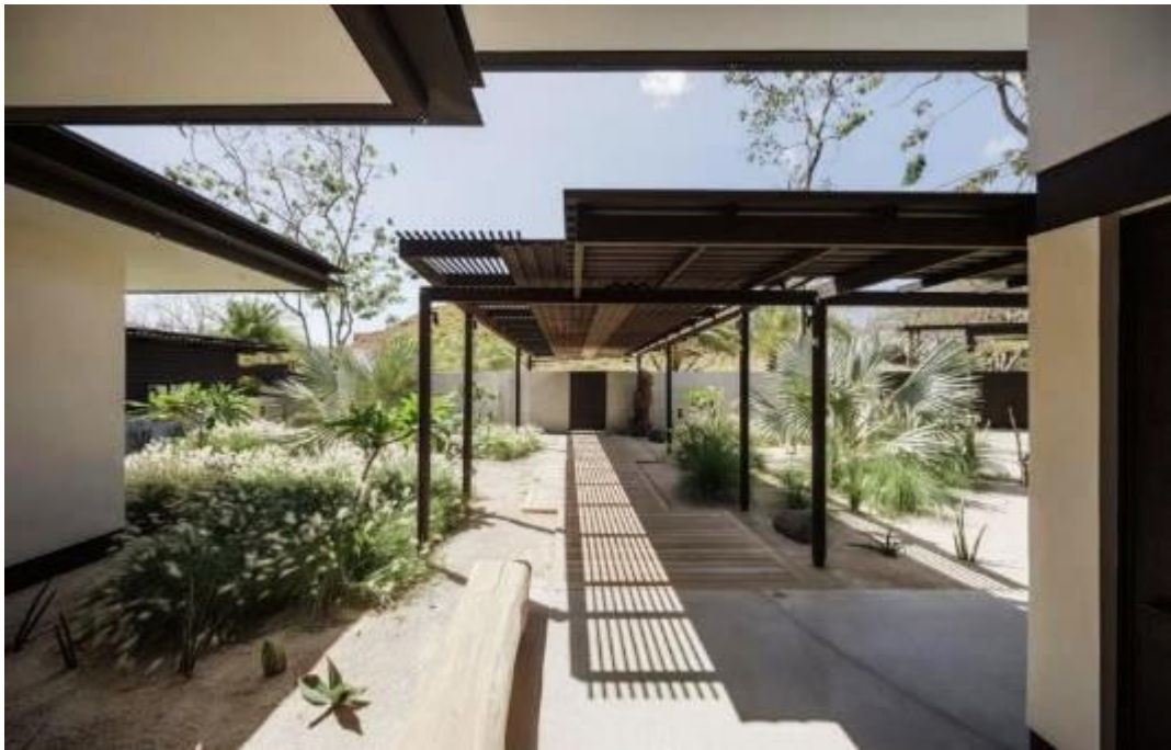
Рисунок А. 23 – Внутренний двор индивидуального жилого дома (проход-галерея).
