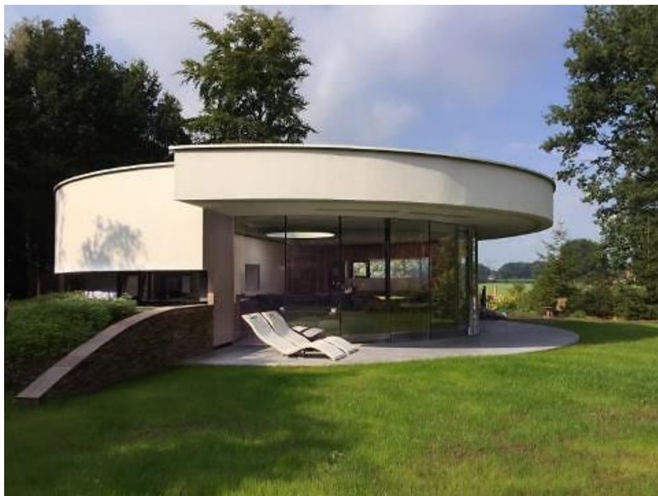
Рисунок А. 11 – Индивидуальный жилой дом (пример 3). Вид на фасад с лаунж зоной.
