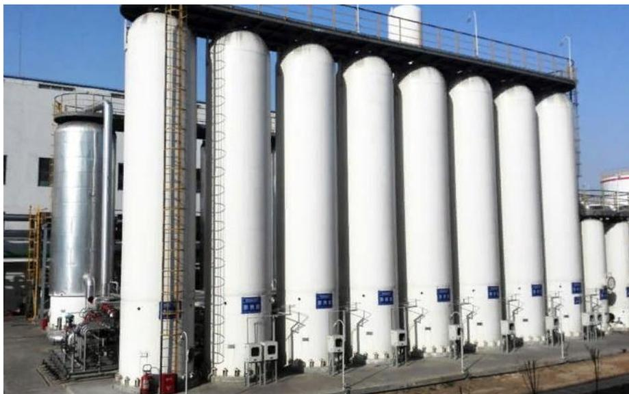
Рисунок 6 – Многоадсорберная КБА-установка
