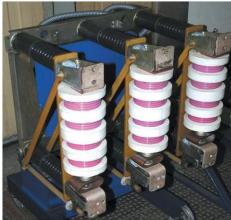
Рисунок 4 – Выключатель ВВУ- СЭЩ-П-35-20/1600
