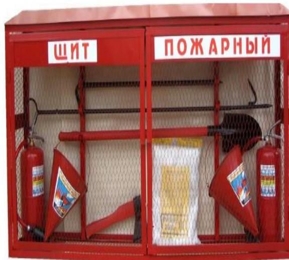
Рисунок 2 – Первичные средства пожаротушения ремонтно-механического завода на АО «Амурский уголь», щит пожарный
