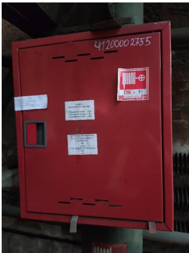
Рисунок 6 – Пожарный шкаф на экскаваторном участке
