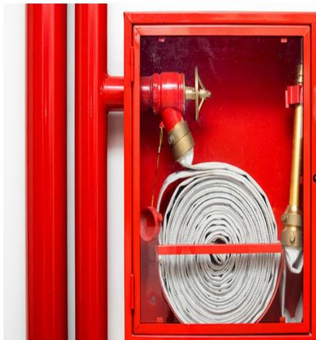
Рисунок 3 - Первичные средства пожаротушения ремонтно-механического завода на АО «Амурский уголь», внутренний пожарный кран
