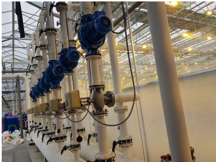
Рисунок 21 – Смесительные группы управления контурами отопления
