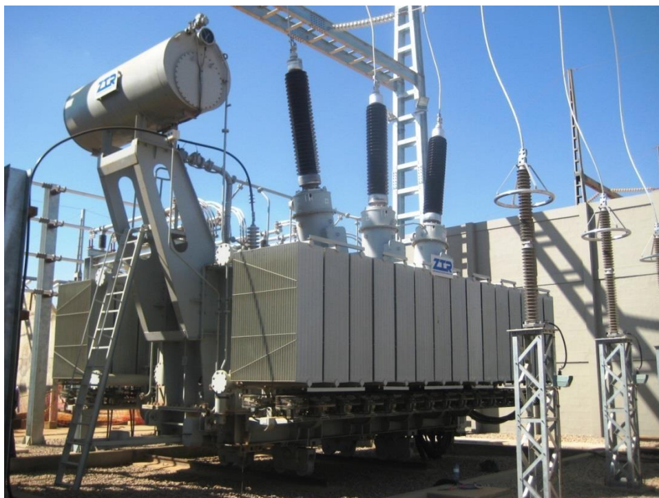
Рисунок 19 - Электромагнитная часть УШРТ
