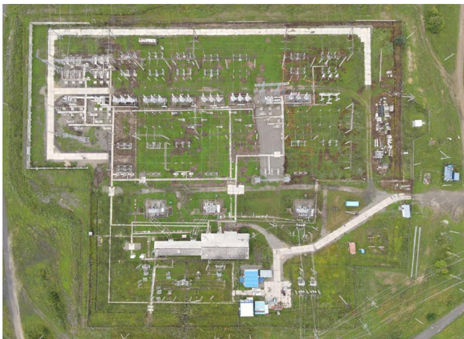
Рисунок 2.2 – Общий вид ПС 220 кВ Магдагачи
