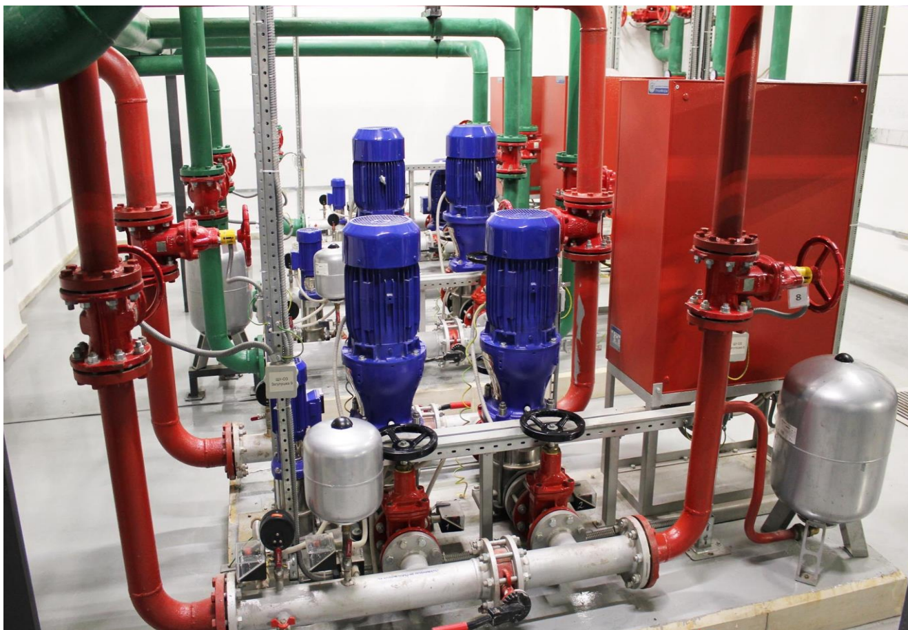
Рисунок 12 – система автоматического водяного тушения.
