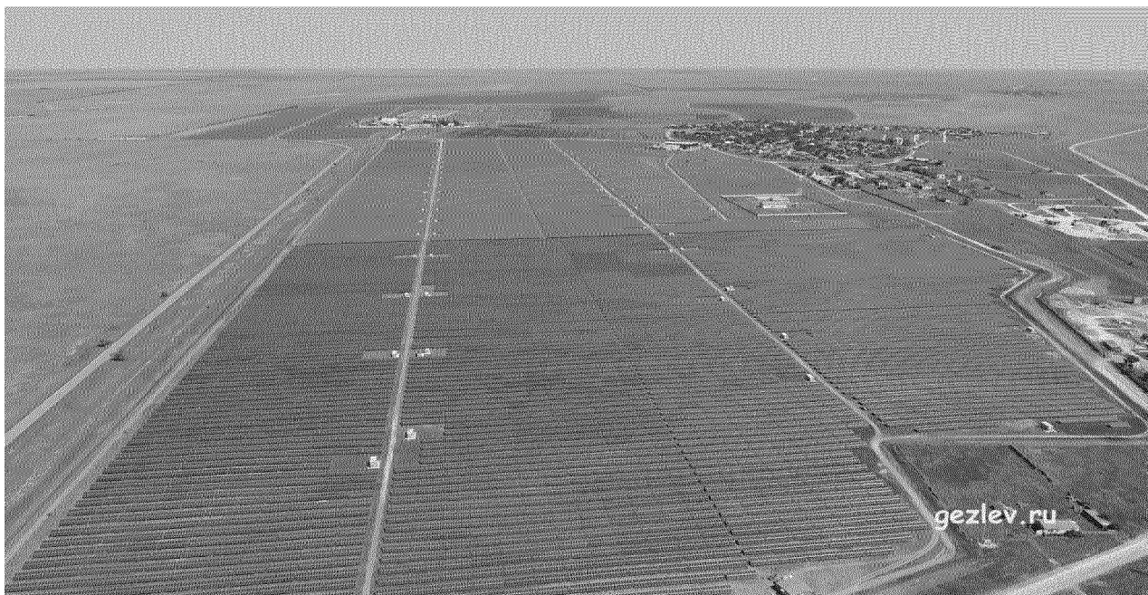
Рисунок 1.10 – Солнечная электростанция «Охотниково»
