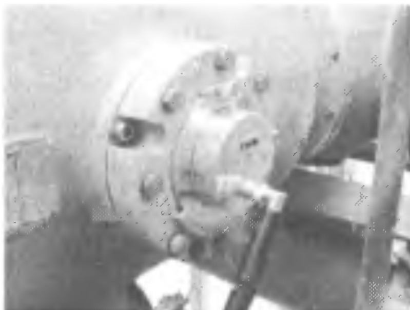
Рисунок 8 - Внешний вид СВЧ-датчика ЧР, встроенного в корпус КРУЭ на номинальное напряжение 500 кВ.
