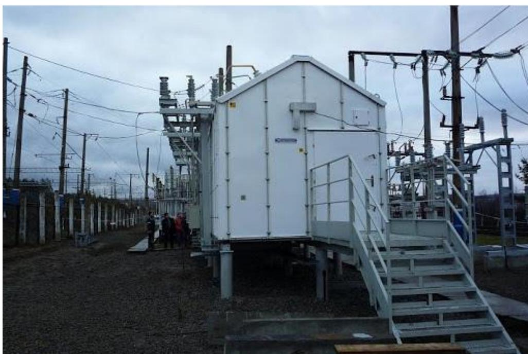
Рисунок 23 – Наружная установка мобильного КРУ
