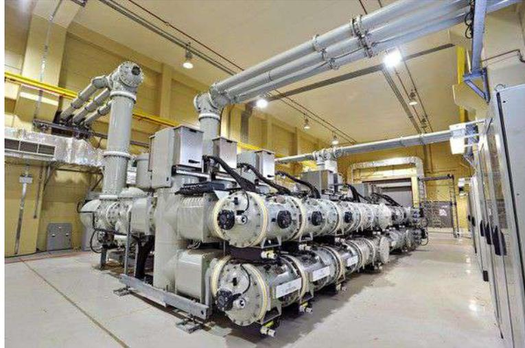
Рисунок 24 – КРУЭ Siemens 8DN9
