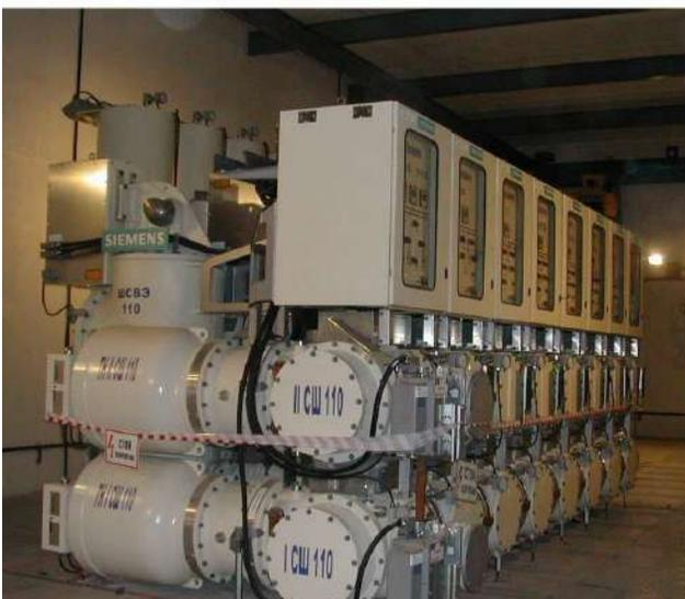
Рисунок 25 – КРУЭ Siemens 8DN8
