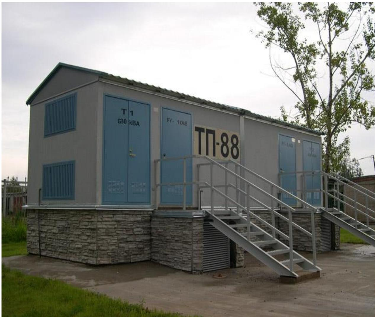
Рисунок 3 – ТП-88 с трансформаторами ТМ-630/10/0,4 кВ
