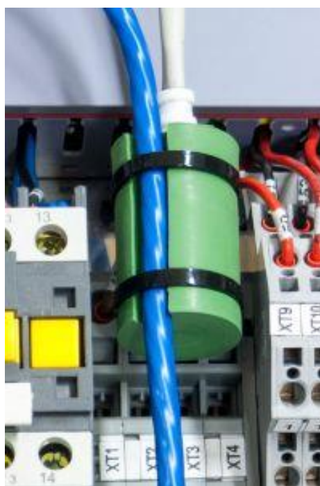
Рисунок 14 – Внешний вид датчика тока марки CSS
