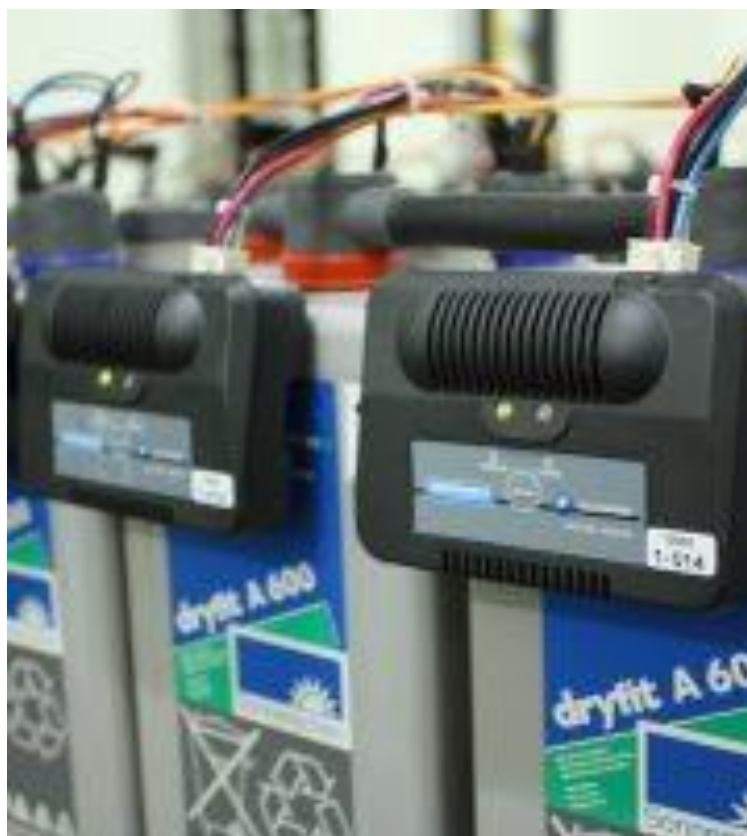
Рисунок 9 - Универсальная беспроводная система мониторинга Cellguard System.
