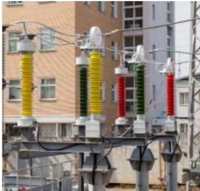
Рисунок 4 - Электронно-оптические трансформаторы
