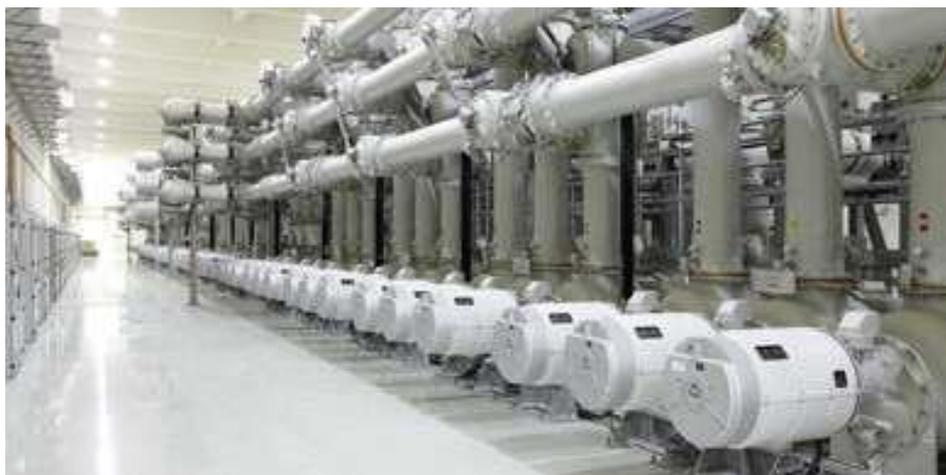
Рисунок 10 – Комплектное распределительное устройство с элегазовой изоляцией
