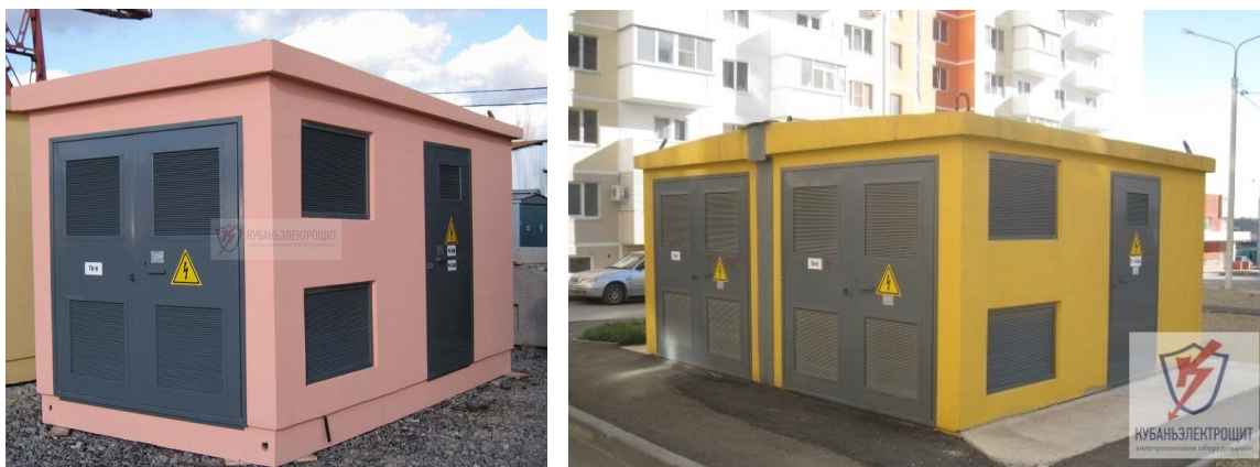
Рисунок 3.2 – пример внешнего вида БКТП и 2БКТП
