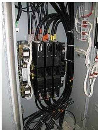
Рисунок 17 – Автоматический переключатель питания дата-центра
