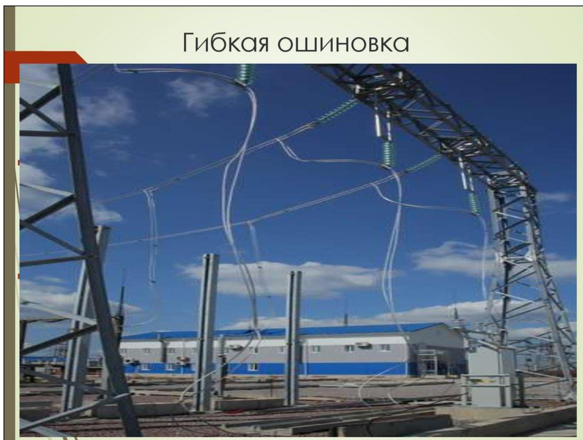
Рисунок 4 - Гибкая ошиновка
