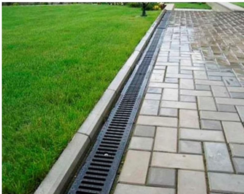
Рисунок В.3 – Пример водоотвода
