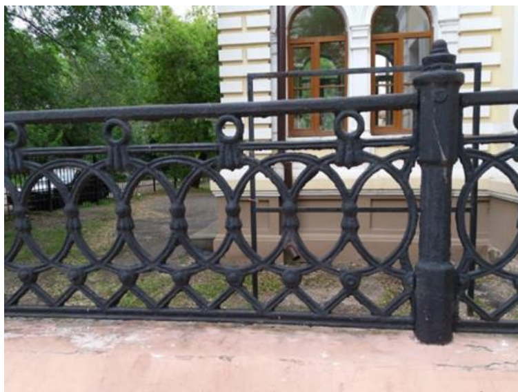
Рисунок В.4 – Пример ковано-сварочного конструктивного элемента
