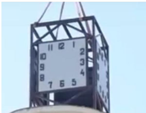
Рисунок В.8 – Закрепление цифер- блата часов на каркасе башни
