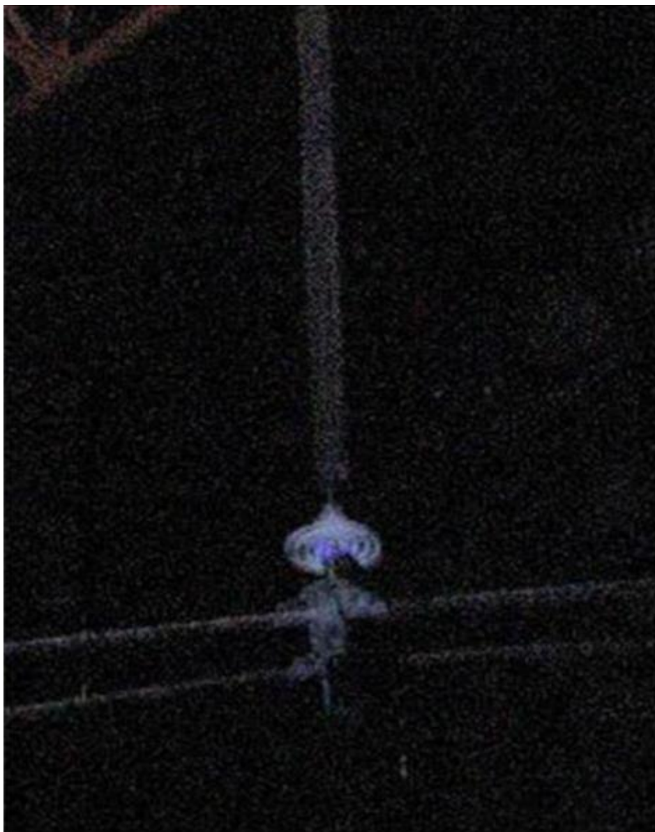
Рисунок 25 – Фотография коронирующего изолятора ПС120Б
