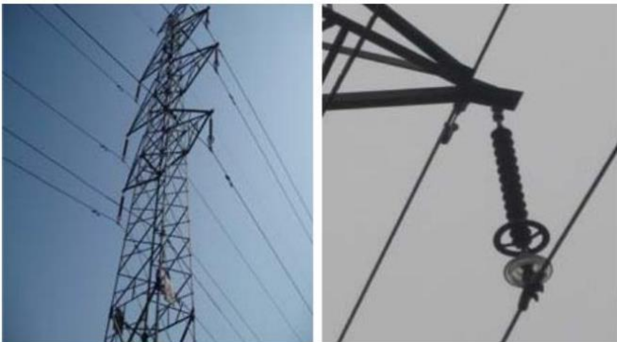
Рисунок 21 – Полимерный изолятор с экраном и стеклянным изолятором
