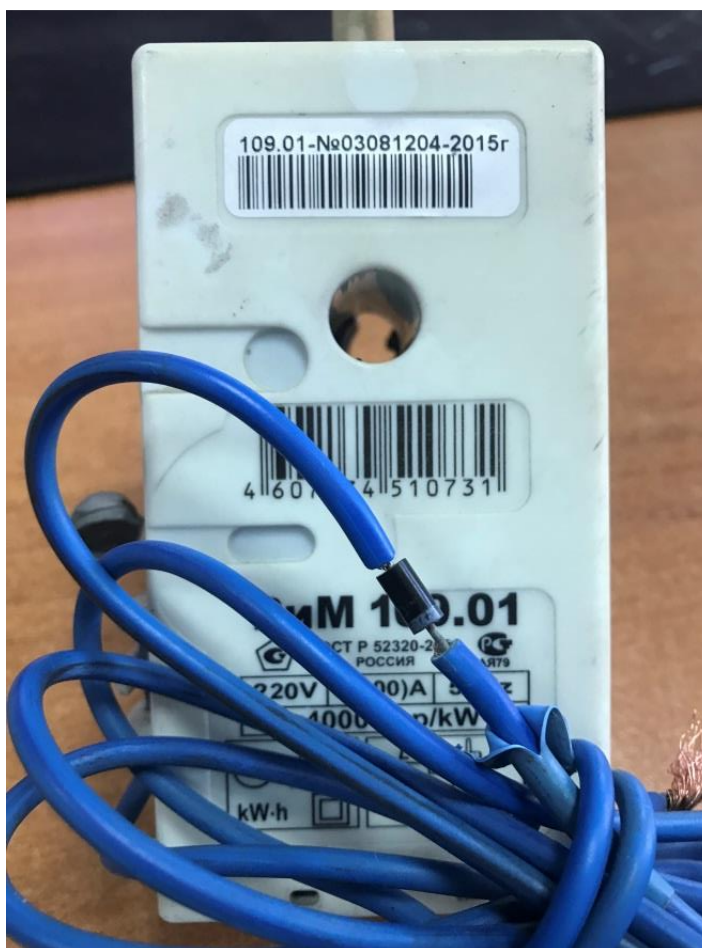
Рисунок 18 – Монтаж диода в нулевой провод
