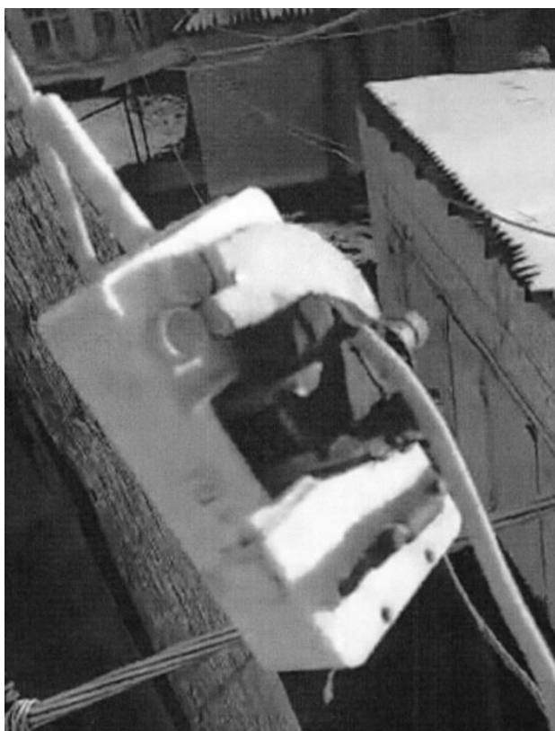
Рисунок 17 – Магнит на корпусе ПУ РиМ
