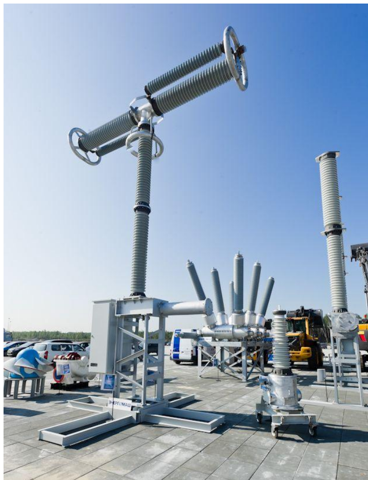
Рисунок 3 - Внешний вид выключателя ВГТ - 500
