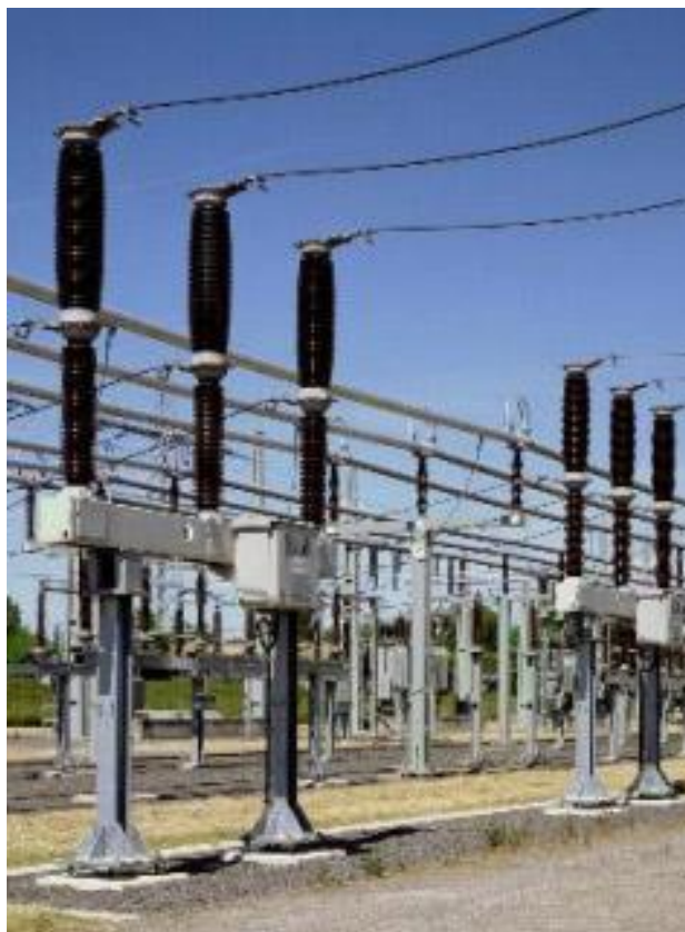
Рисунок 4 – выключатель элегазовый GL-314
