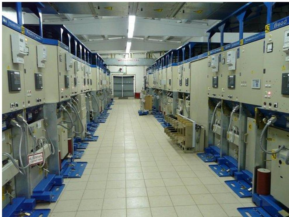
Рисунок 9 – КРУ СЭЩ-63 производства ОАО «Электроцит САМАРА»
