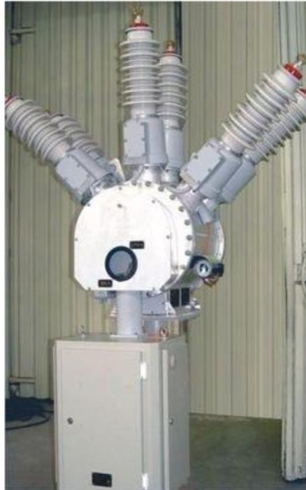
Рисунок 6 – Выключатель ВГБЭ-35
