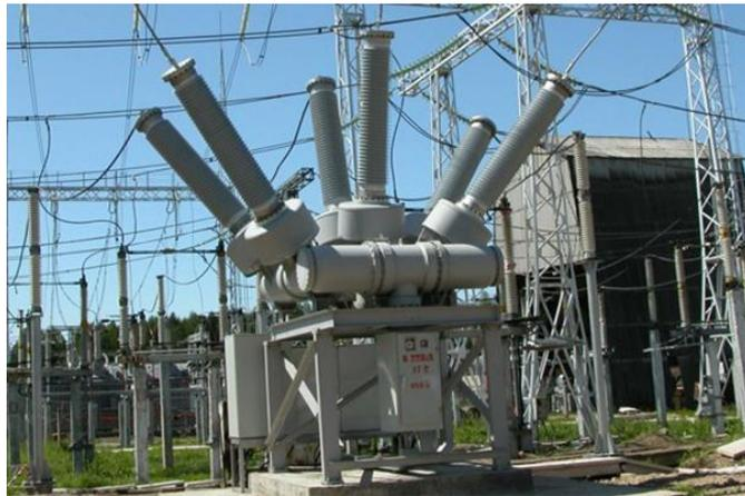
Рисунок 5 – Выключатель ВГБУ-220
