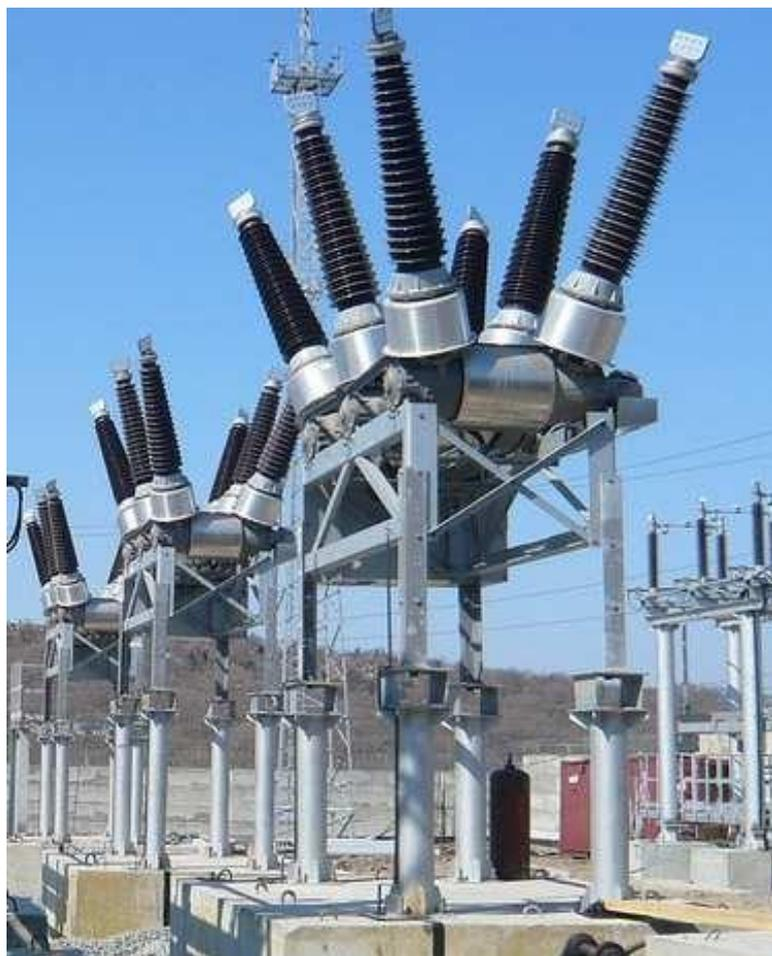
Рисунок 3 – Элегазовый баковый выключатель 110 кВ с фарфоровой изоляцией вводов типа ЗАР1DT-145/ЕК.
