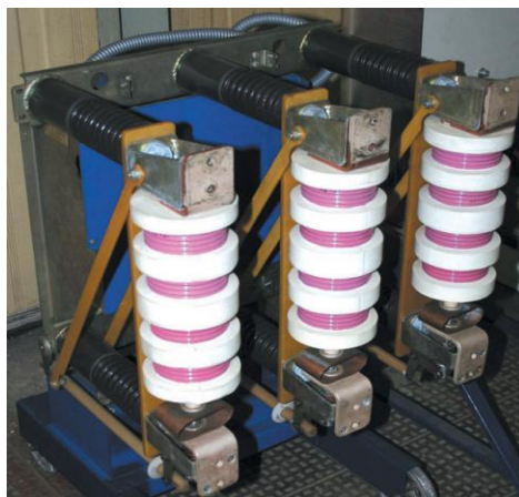
Рисунок 3 – Выключатель ВВУ- СЭЦ-П-35-20/1600
