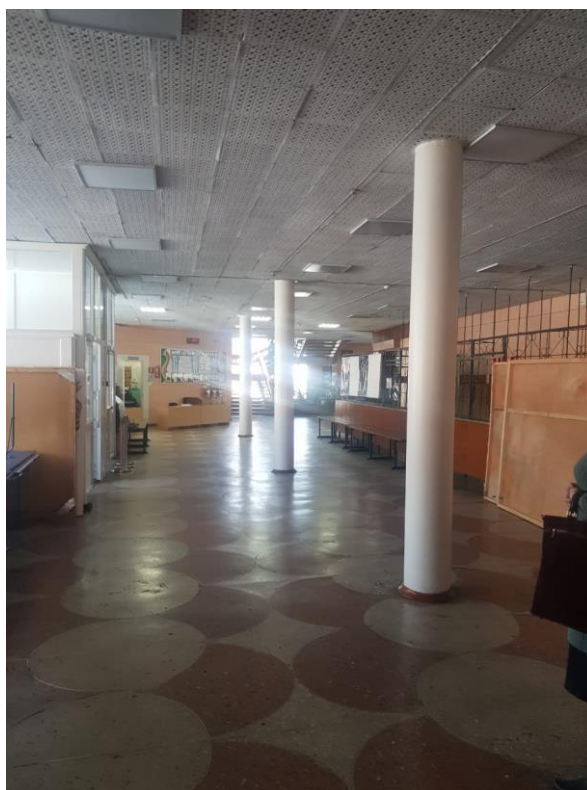
Рисунок А.2 – Холл 1го этажа
