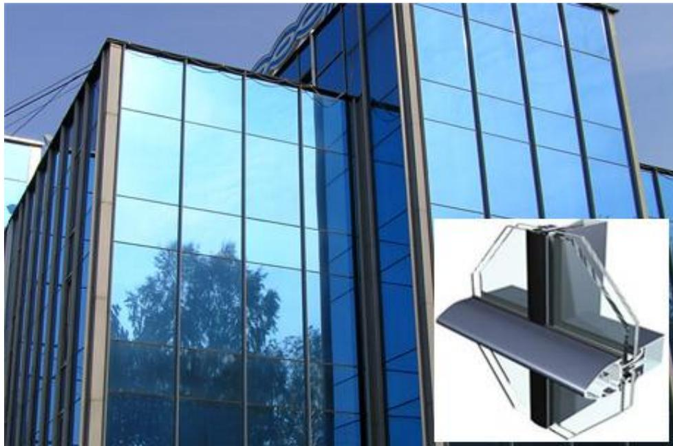
Рисунок В.9 – Полуструктурная система остекления
