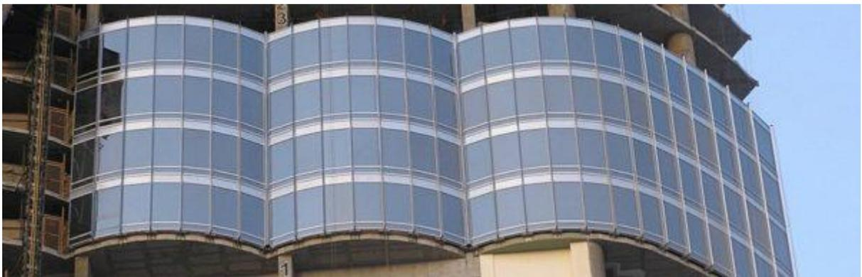
Рисунок В.10 – Модульная система остекления
