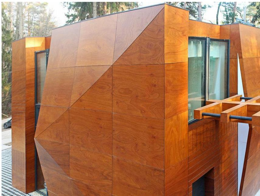
Рисунок В.7 – Фасадные шпонированные панели
