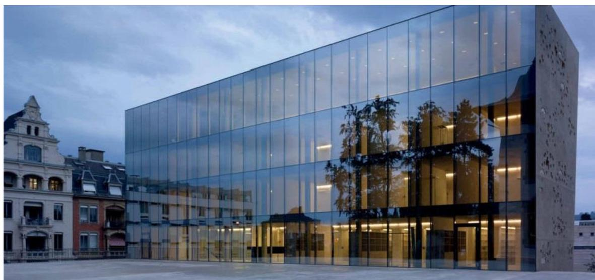
Рисунок В.8 – Структурная система остекления
