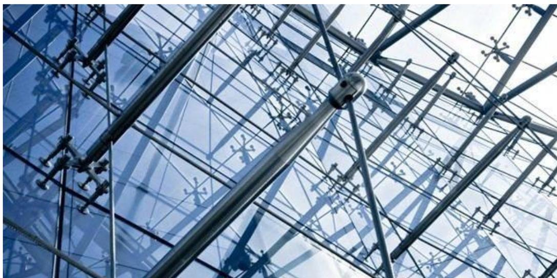
Рисунок В.12 – Вантовая система остекления
