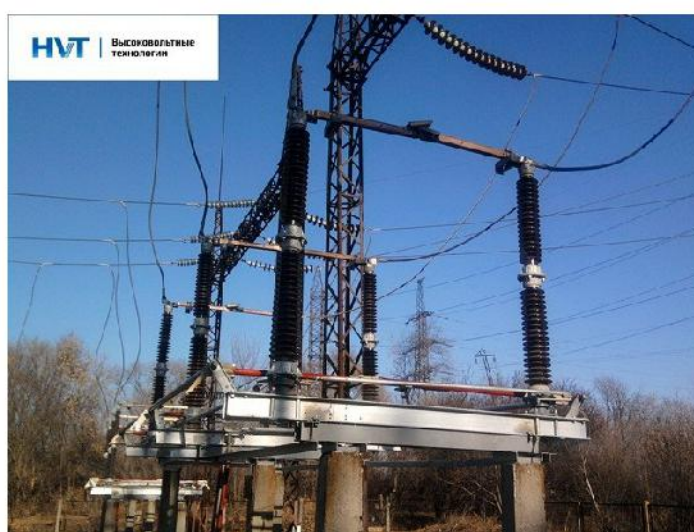
Рисунок 12 – Разъединители РНДЗ.
