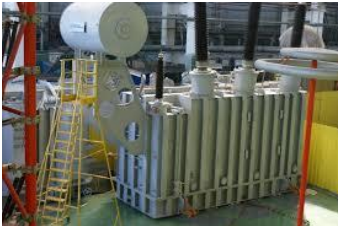
Рисунок 10 – Внешний вид ТРДН-63000/220 УХЛ1
