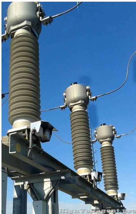
Рисунок 19 - Внешний вид трансформатора тока
