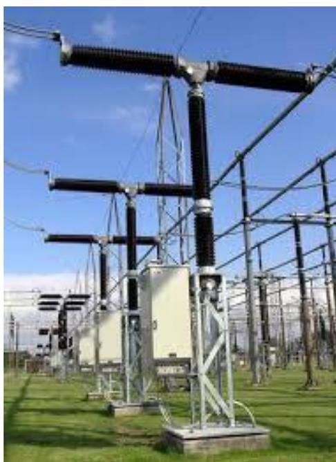
Рисунок 16 - Внешний вид выключателя LTB145D1/B
