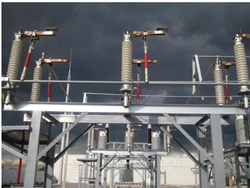
Рисунок 18 - Внешний вид разъединителя марки РДЗ.2-110/1000УХЛ1
