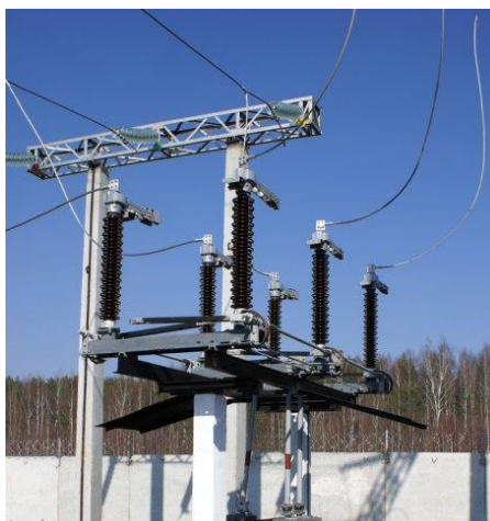
Рисунок 14 - Внешний вид разъединителя марки РДЗ.2-110/1000УХЛ1
