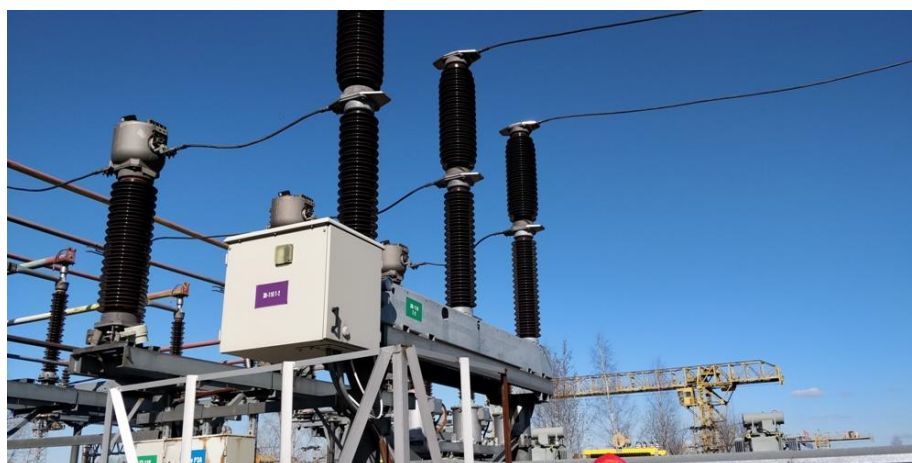
Рисунок 13 - Внешний вид выключателя LTB145D1/B
