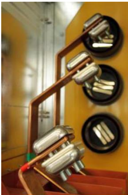
Рисунок 13 – Отсек сборных шин ячеек РІХ - Н
