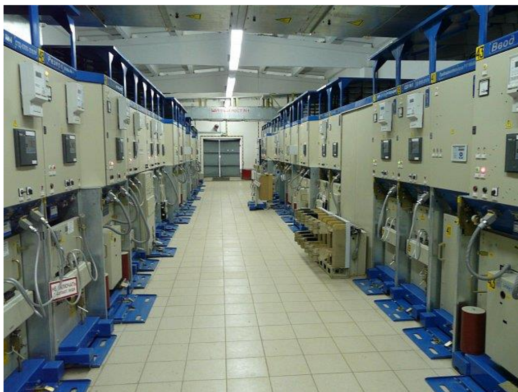
Рисунок 9 – КРУ типа К-63 производства ОАО «Электроцит» г.Самара
