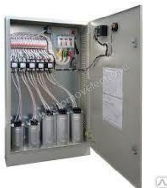
Рисунок 5 - установка конденсаторная, серии УКМ 58-0.4
